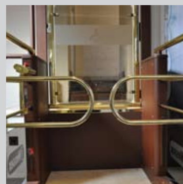
Barrières Montées sur la Plateforme
